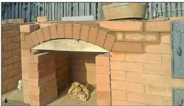
6 Арку выкладываю по самодельному кружалу.
