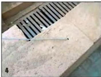
4 Дверки креплю в кладке проволокой (использую электроды для сварки), которую завожу не в швы, а в специально просверленные в кирпиче отверстия. Колосники ставлю по всей длине топки.
