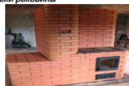
7 Основа будущего разделочного стола с проёмом для установки раковины подготовлена.
