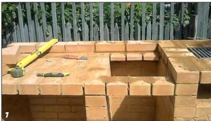
7 Основа будущего разделочного стола с проёмом для установки раковины подготовлена.
