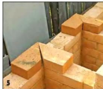
5 Кирпич в местах стыка стенок пилю от угла к середине, что позволяет получить надёжную перевязку швов.
