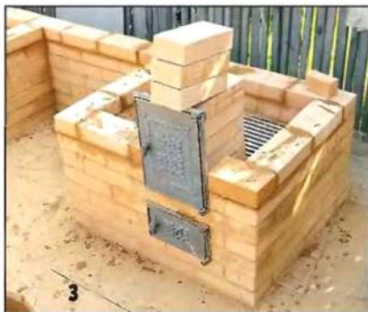
3 Топочную дверку на время кладки нужно надёжно зафиксировать.
