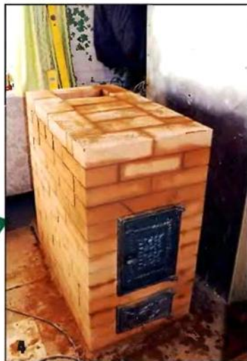
Топочная камера перекрыта.
