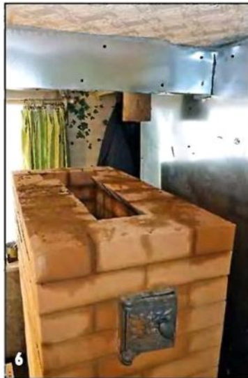
Топка и горизонтальные дымоходы перекрывались двумя рядами с тщательной подгонкой кирпичей.
