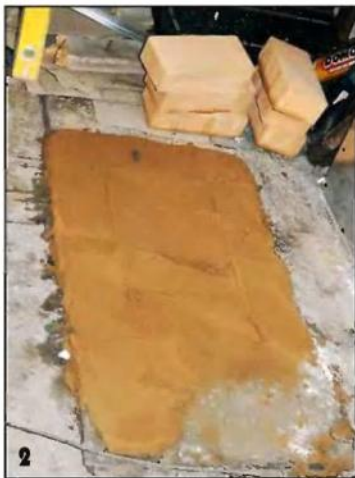
Кирпичную печь кладут на подготовленный фундамент.
