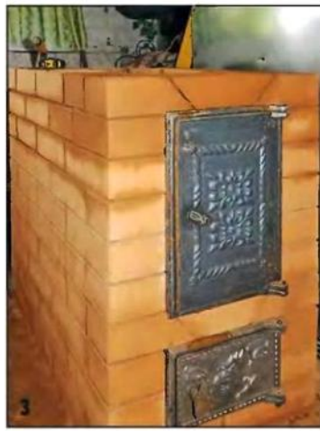
Проёмы над дверками зольной камеры и топки перекрываю «в замок».
