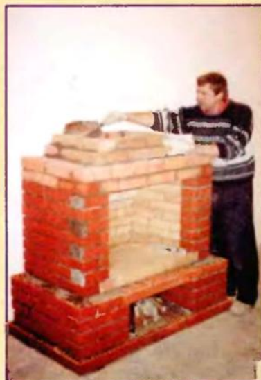
Фото 3. После перекрытия топки камин формируют дымоборник. Топочную часть камин, как и сам дымоборник, выкладывали на глиняно-песчаном растворе. Отверстие, оставленное строителями в стене для входа в дымовую трубу, пришлось замуровать, как не соответствующее выбранной конструкции очага.
