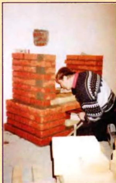
Фото 2. Сложив подину из шамотного кирпича, приступили к кладке боковых стенок портала.
