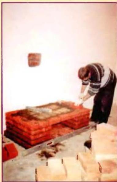
Фото 1. Кладку нижней части камин (в сочетании с дровницей) выполняли из облицовочного кирпича на цементно-песчаном растворе. На перекрытие дровницы использовался полнотельный кирпич марки М-150.
