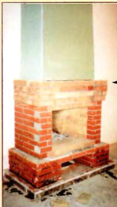
Фото 4. Так выглядит камин в «черновом» виде. Для установки фальш-зонта, скрывающего дымоборник, использовали профили из оцинкованной стали и гипсоволокнистые листы, которые закрепили к профилям саморезами. Внутренняя сторона гипсоволокнистых листов оклеена алюминиевой фольгой. Контрольной топкой проверили тягу и после этого приступили к облицовке камина.
