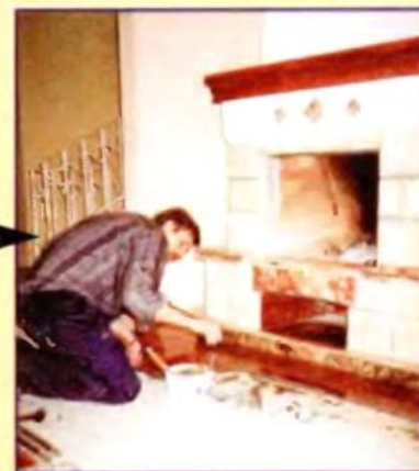
Фото 4. Так выглядит камин в «черновом» виде. Для установки фальш-зонта, скрывающего дымоборник, использовали профили из оцинкованной стали и гипсоволокнистые листы, которые закрепили к профилям саморезами. Внутренняя сторона гипсоволокнистых листов оклеена алюминиевой фольгой. Контрольной топкой проверили тягу и после этого приступили к облицовке камина.
