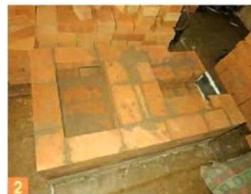
Верх печи выложил в 2,5 кирпича на 4,5 кирпича, то есть 63x114 мм. Получилась своеобразная полочка (поясок), зрительно разделяющая печь на два уровня. В верхней части печи устроил бортик с выступом, напоминающим карниз как завершающий элемент декора.
